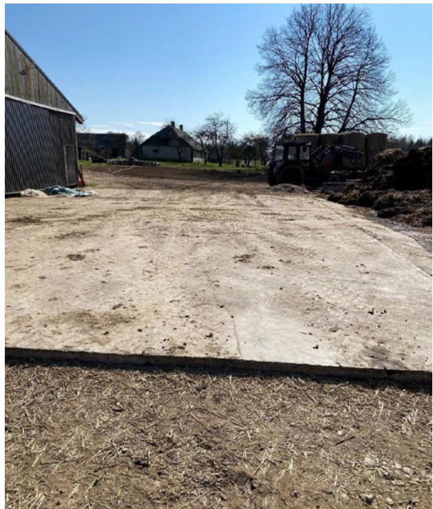
5. foto. Kaldega betoonist alus on silomahla kogumiseks tõhus lahendus. Foto: Iveta Grudovska
