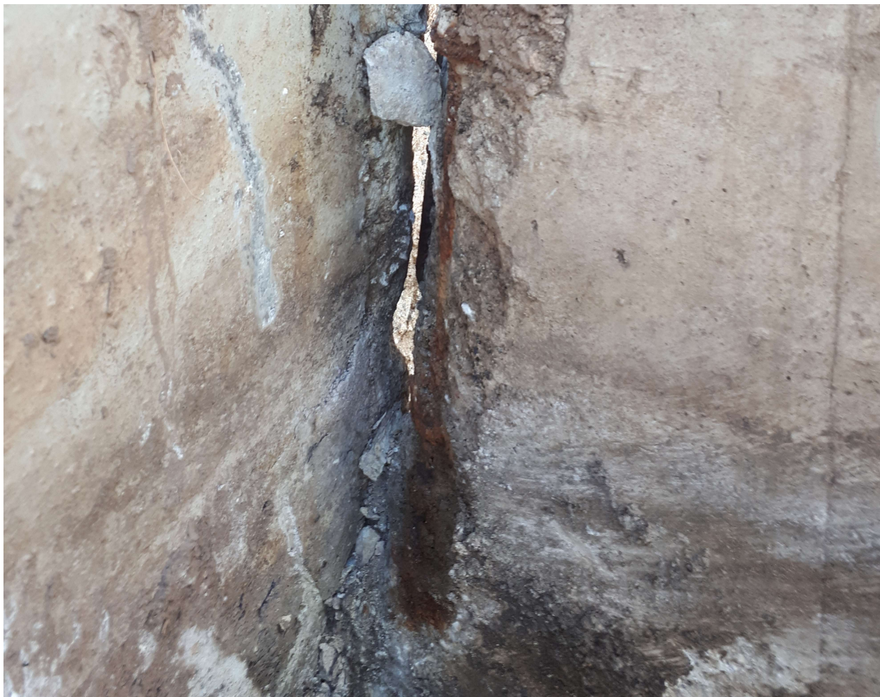
Armatuuri korrosioonikahjustused
